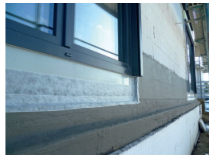
Uszczelnienie stolarki okiennej przy zastosowaniu PCI Barraseal ® Turbo oraz taśm uszczelniających PCI Pectitape ® .
