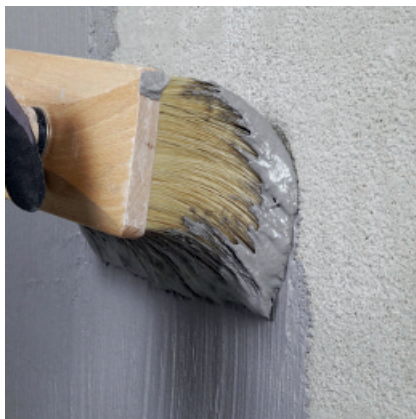
Warstwa kontaktowa nakładana pędzlem.
