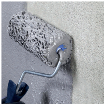
Warstwa kontaktowa nakładana wałkiem
